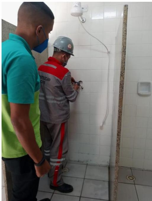
Figura 51: Manutenções em hidráulica (conserto de vazamentos)
